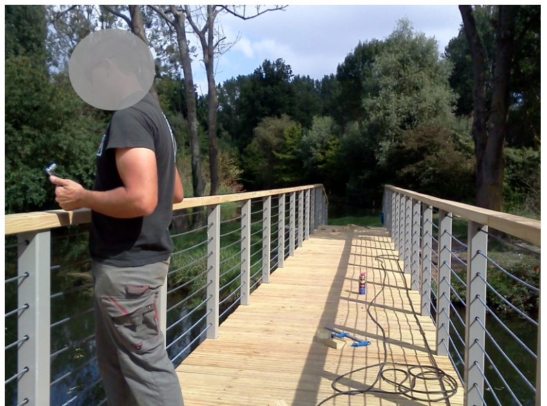
Passerelle franchissement rivière
