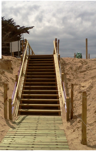
Escalier amovible sur contre-poids pour permettre le rechargement de la dune hors saison touristique
