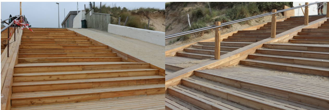
Bardage et remplacement rampe sur un escalier béton
