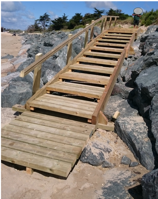
Escalier fixé sur des enrochements, démontable hors saison touristique
